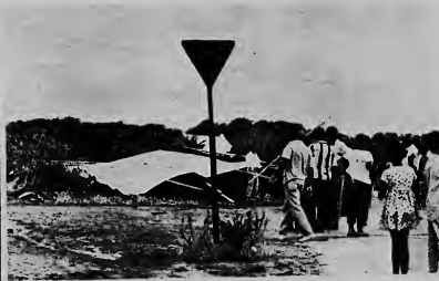
Na momento cu e dak tabata den halto ela kibra algun waya di electricidad den e vecindario. Lo mas pensoso ta, cu apenas dos siman pasa e dak aki a ser pone, despues cu e casa a hanja un renobacion completo.
